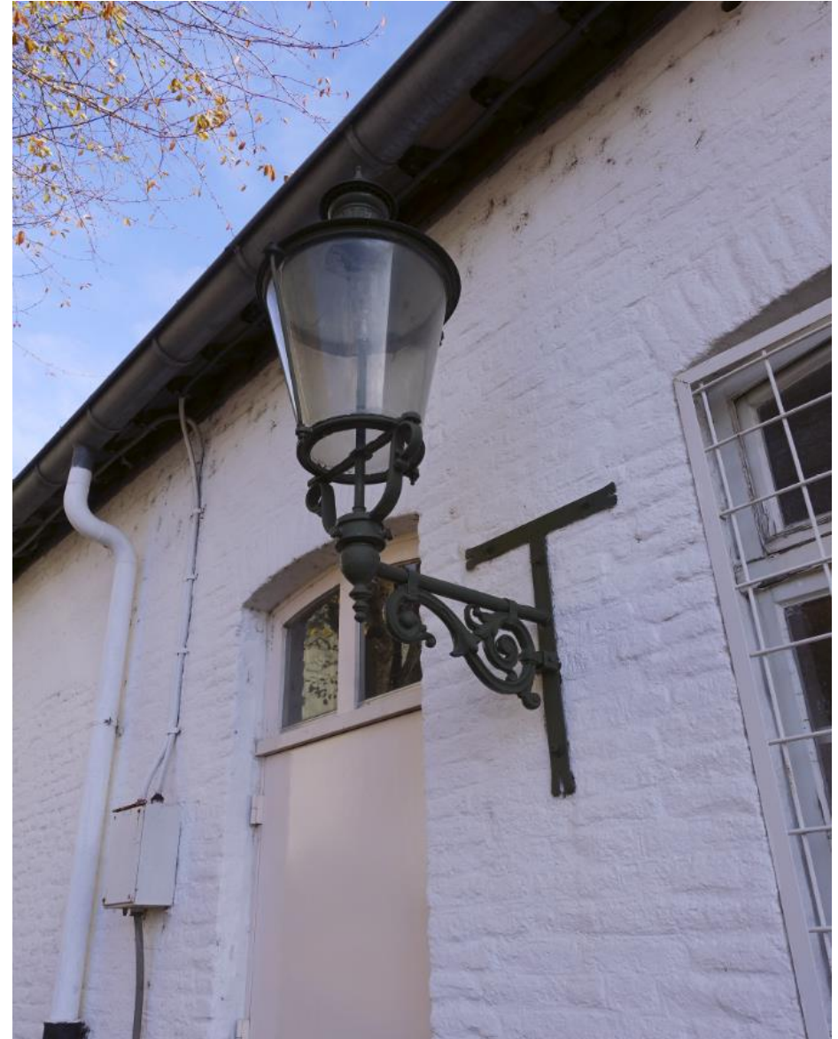
Zicht op de gietijzeren lantaarn tegen de westgevel van de loods.
