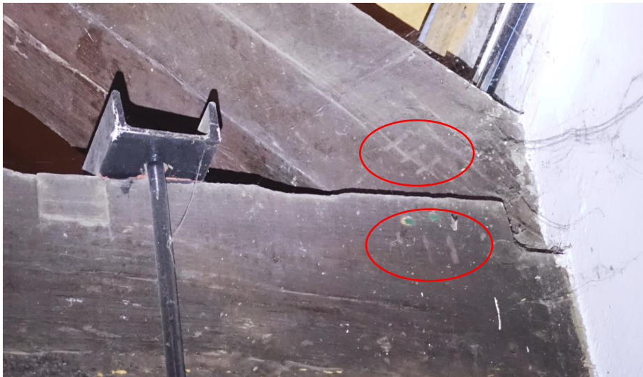
Detail van de westzijde van een juk met op de onderste dekbalk en onderzijde spantbeen een gehakt telmerk in de vorm van drie strepen (III).
