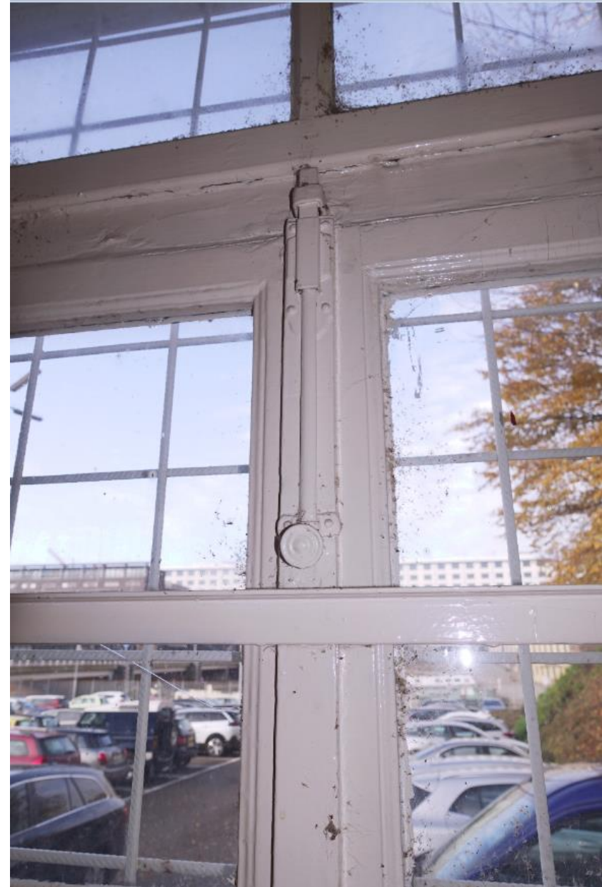
Binnenzijde van de draairamen met een detail van de sluiting aan de bovenzijde.
