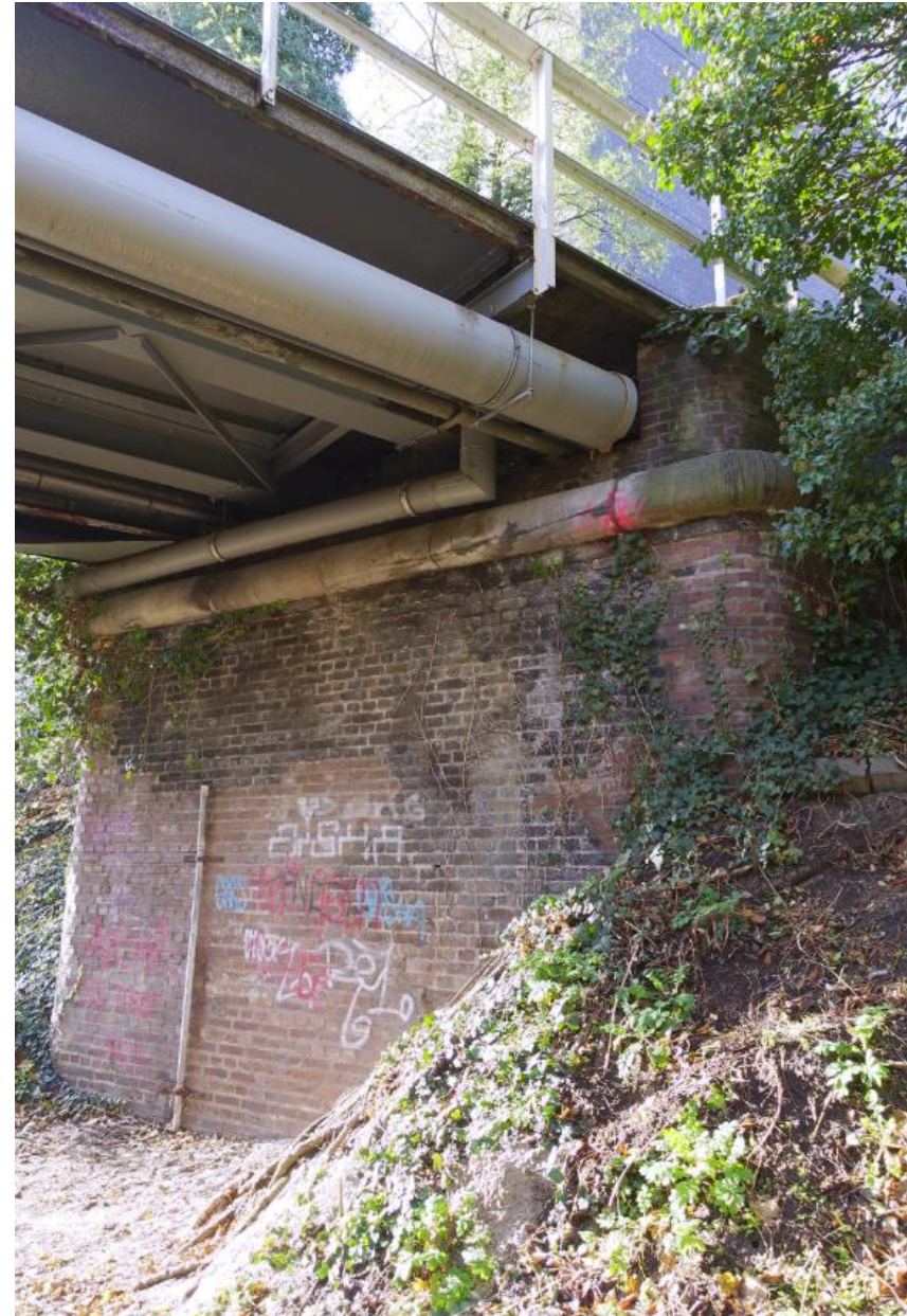
Het westelijke landhoofd aan de waterzijde.
