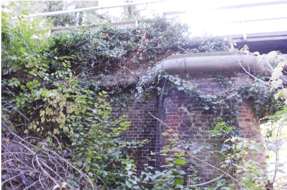
De noordelijke zijde van het oostelijke landhoofd met aansluitende pijler.
