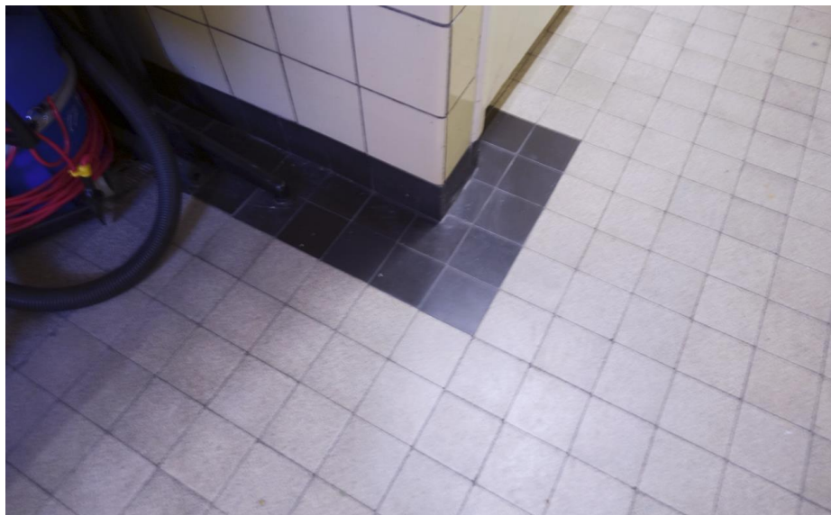
De tegelvloer uit 1940 bij de toiletten.
