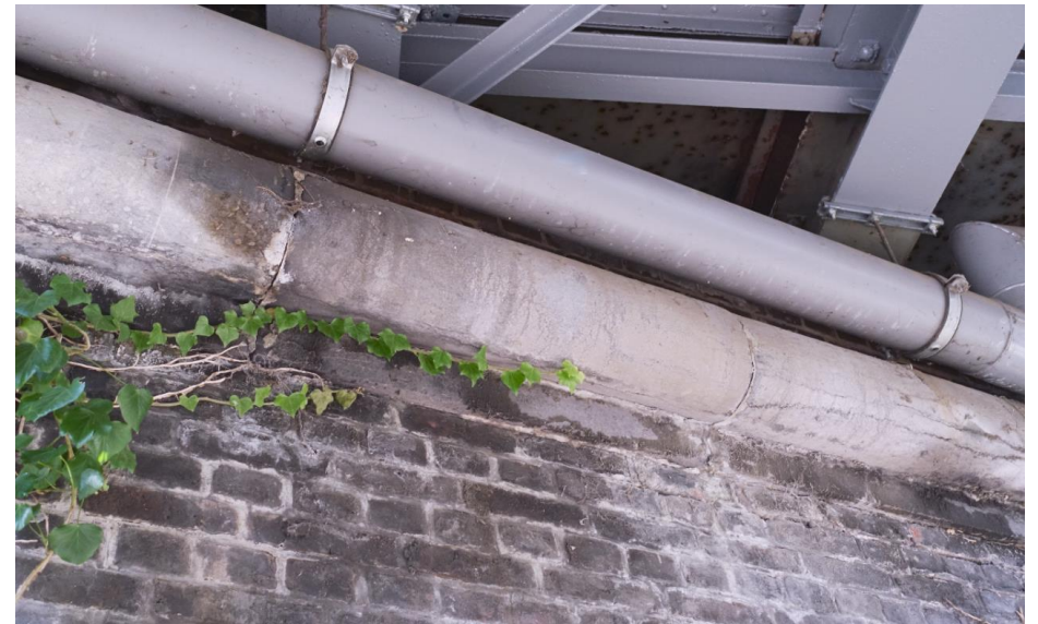
Aan de westzijde bestaat de lijst uit de originele hardstenen blokken.
