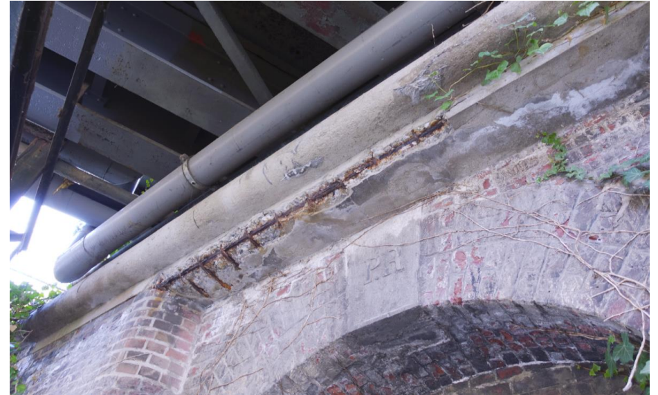
Aan de oostzijde is de halfronde lijst bij de pijler en het landhoofd in 1986 vernieuwd in gewapend beton.
