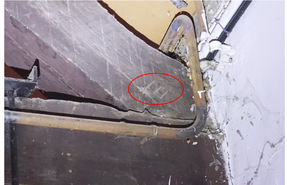
Een tweede juk inde constructie met drie gehakte strepen op de onderzijde spantbeen.
