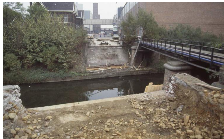
Bouw van een nieuwe brug over het verbindingkanaal naar de papierfabriek in 1983. Rechts is de oude spoorbrug zichtbaar. Afb: RHCL beeldbank, nr. 38488.
