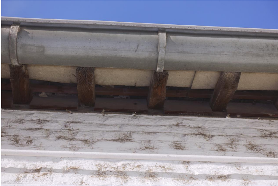
Detail van de bovenzijde van de langsgewels met de klossen en goot uit 1940.
