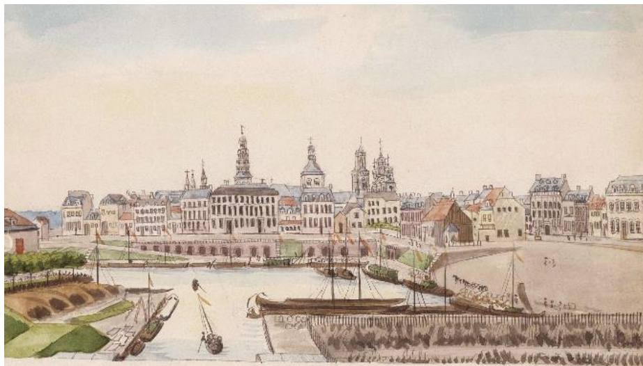
Bassin gezien richting het zuiden op een prent uit 1840. Op de voorgrond de aansluiting van de Zuid Willemsvaart. Afb: RHCL beeldbank, nr. LGOG 471A.
