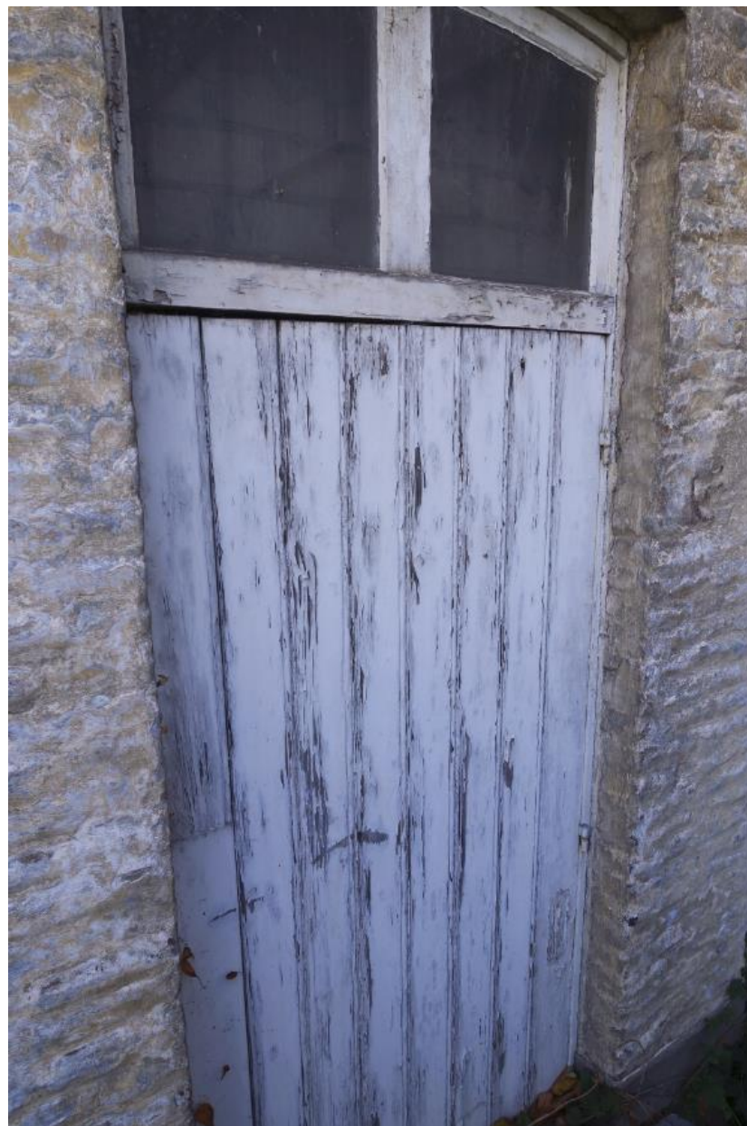
Een oude opgeklampte deur, mogelijk stammend uit 1879-1882 in de westgevel.
