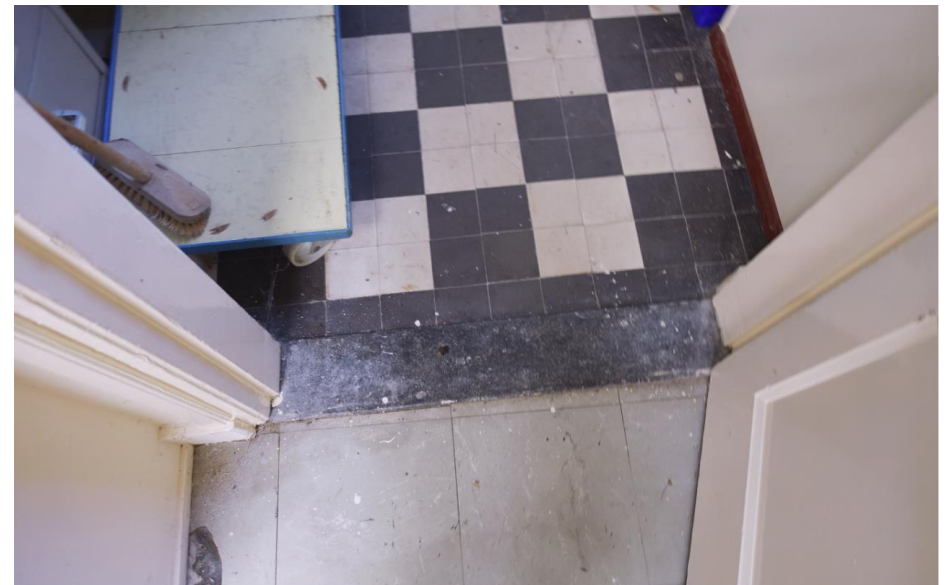
Zicht op de jongere tegelvloer in de repetitieruimte en de vloer in blokpatroon uit 1940 in de naastgelegen vestibule.
