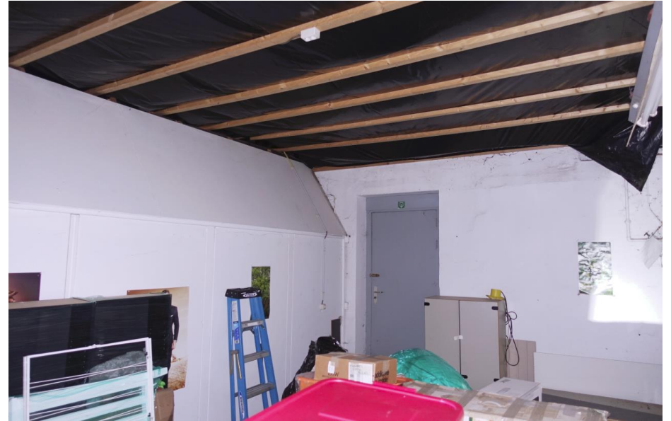
De berging tegen de noordgevel, gezien naar het westen.
