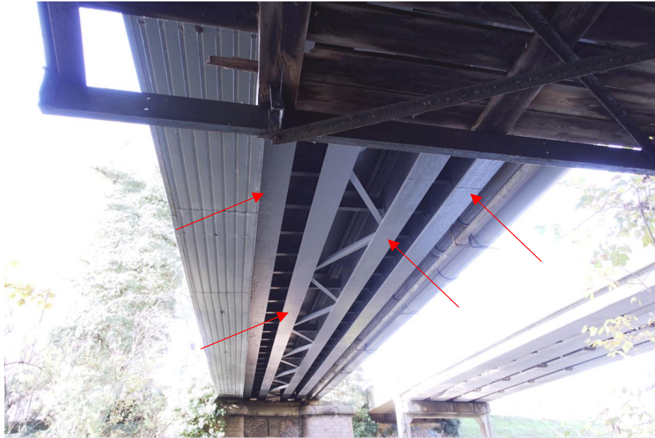
Zicht op de onderzijde van de bovenbouw, gezien vanaf de oostelijke kade. Bij de rode pijlen de vier langsliggers.
