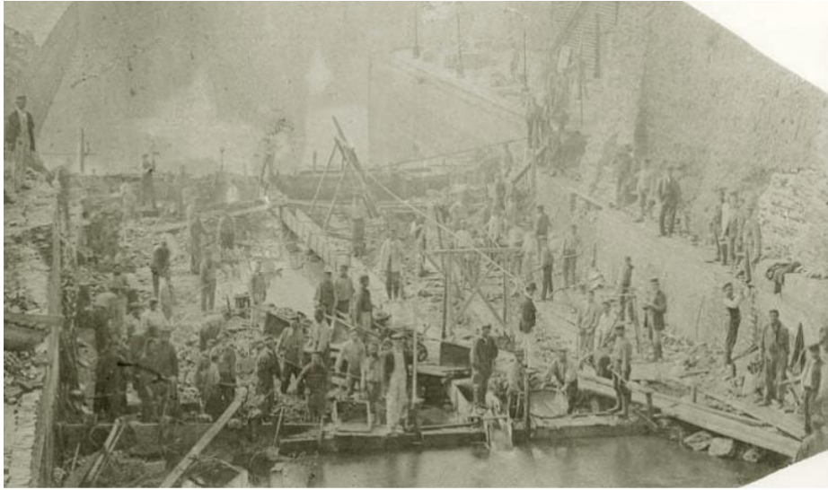
Verbreding van de verbinding tussen de Zuid Willemsvaart en het Bassin in 1865-1870. Later zou over deze verbinding de twee bruggen in de Fransensingel worden aangelegd. RHCL beeldbank, nr. 10507.
