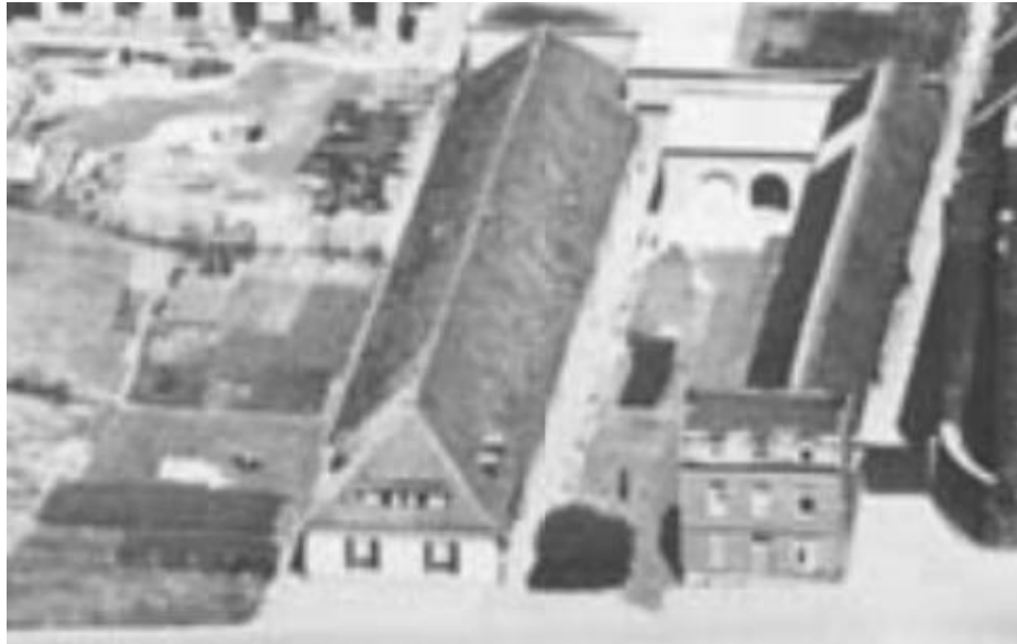
Uitsnede van de loods uit de luchtfoto vlak voor de sloop van de zuidgevel en het dakschild. Afb: RHCL beeldbank, nr. 10549.
