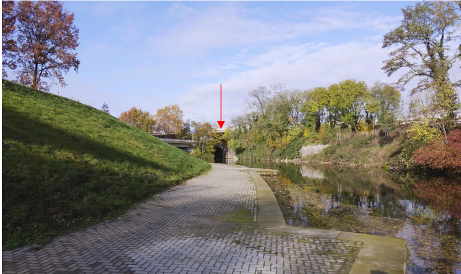
De verbinding tussen Bassin en Zuid Willemsvaart richting het noorden. Bij de pijl is de oude overkluizing van de vaart zichtbaar. Het voetgangerspad is hier breder uitgevoerd en bereikbaar via een trap die toegang biedt vanaf het talud aan de linkerzijde.
