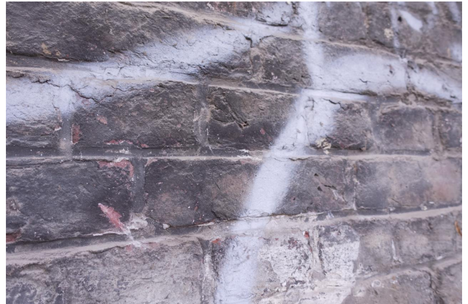
Detail van het metselwerk met voegwerk uit 1876 in de vulling van de boog aan de oostzijde.
