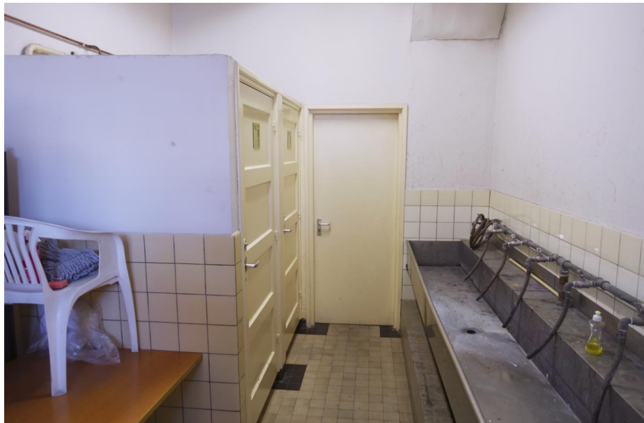
De toiletruimte uit 1940 gezien richting het oosten. De stalen wasbak rechts is vernieuwd.
