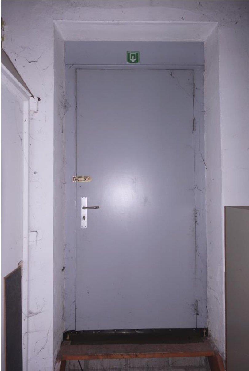
Een recent aangebrachte vlakke deur in de westgevel.
