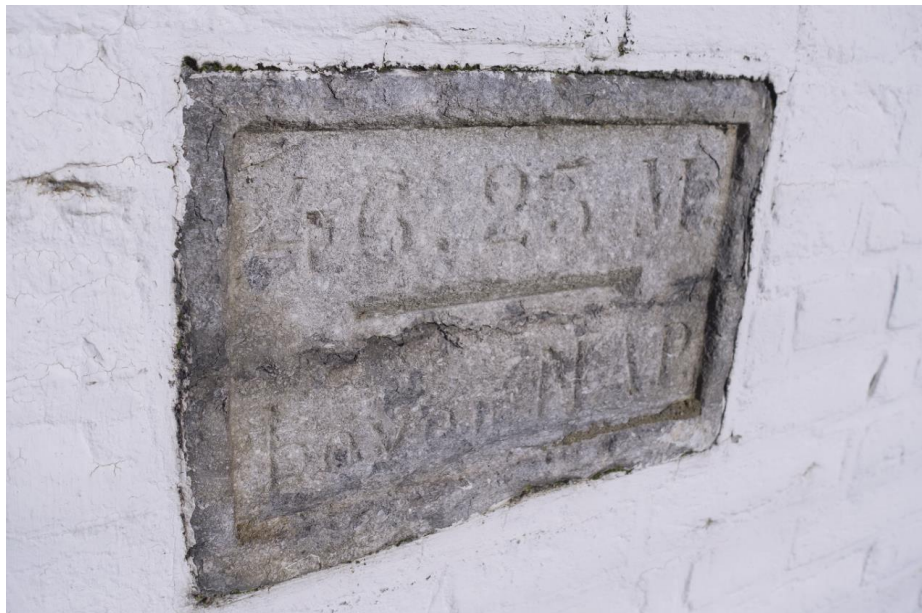
Oude hardstenen hoogtesteen in de zuidelijke topgevel van de loods.
