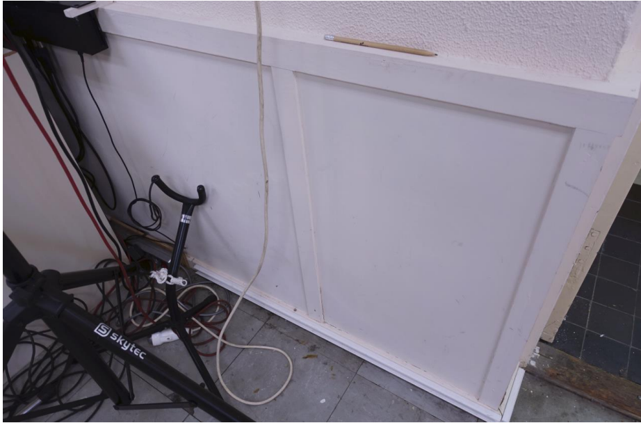
Jonge lambrisering van geperst hout in de repetitieruimte.
