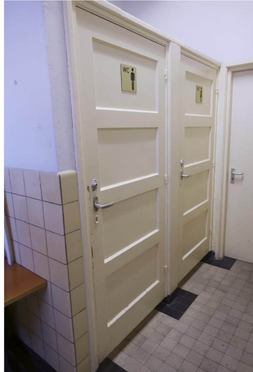
Oude Bruynzeeldeuren bij de toiletten uit 1940.
