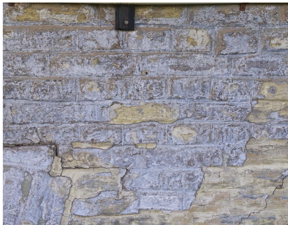
Detail van het metselwerk uit 1827 met het gesneden en met daggerstrepen uitgevoerde voegwerk.
