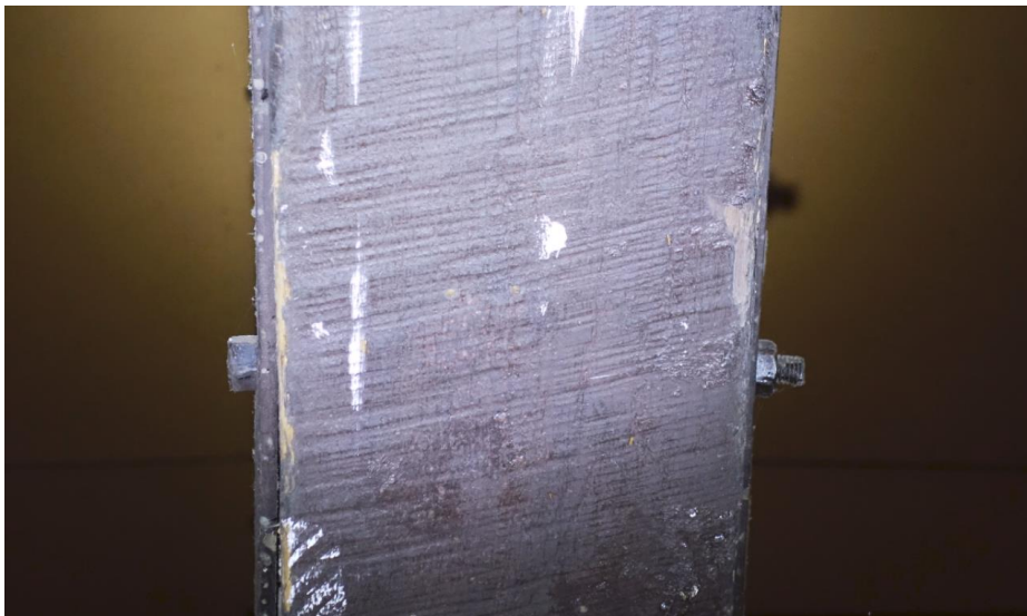
Detail van de onderzijde van de onderste dekbalk met onregelmatige afdruk van de handzaag.
