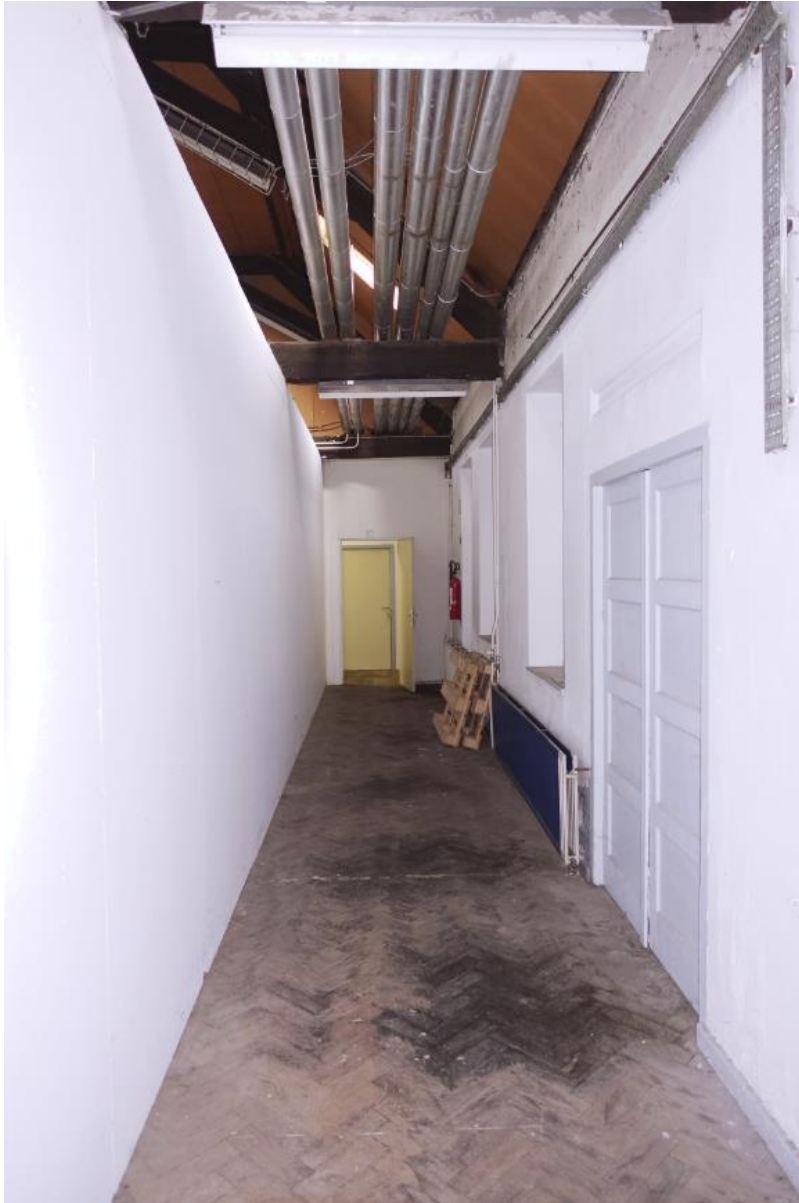
De gang tegen de oostgevel die het schildersatelier met de berging van de carnavalsvereniging verbindt.
