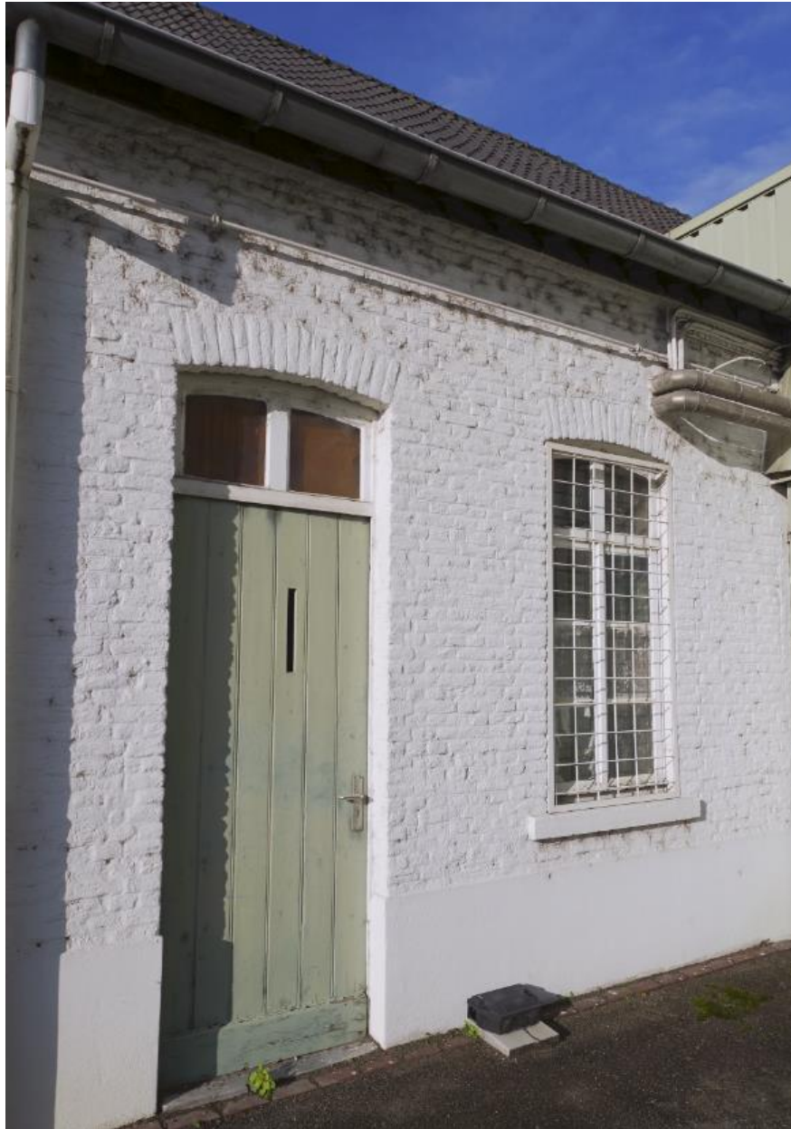
Oude toegang met opgeklampte deur en venster met 6-ruits vulling in de oostgevel.
