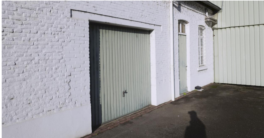
In 1965 zijn er aan de zuidkant van de oostgevel nieuwe openingen gemaakt, gevuld met garagedeuren.
