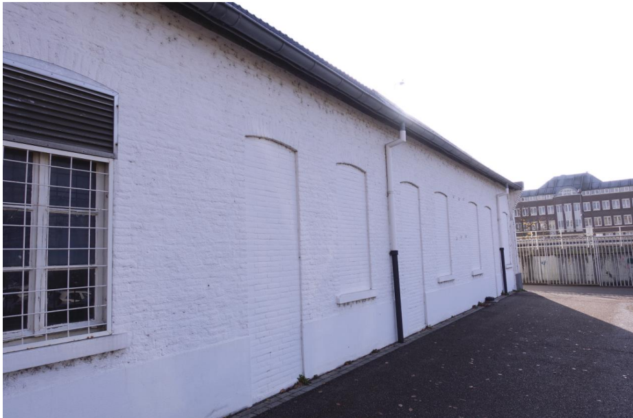
Dichtgezette openingen aan de zuidzijde van de westgevel.
