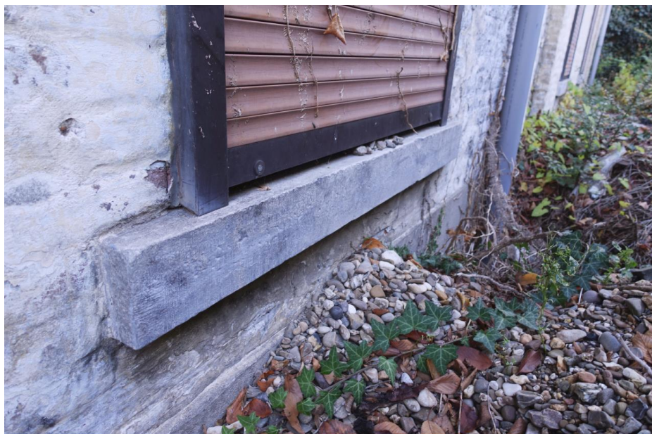
Hardstenen lekdorpel met frijnslag uit 1879-1882 bij een van de vensters in de westgevel.
