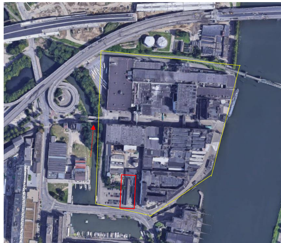
Huidige situatie van het fabrieksterrein (gele lijnen) van de SAPPI gezien vanuit de lucht. Bij de rode pijl de voormalige spoorbrug, bij de omlijning de loods. Afb: Google Maps.
