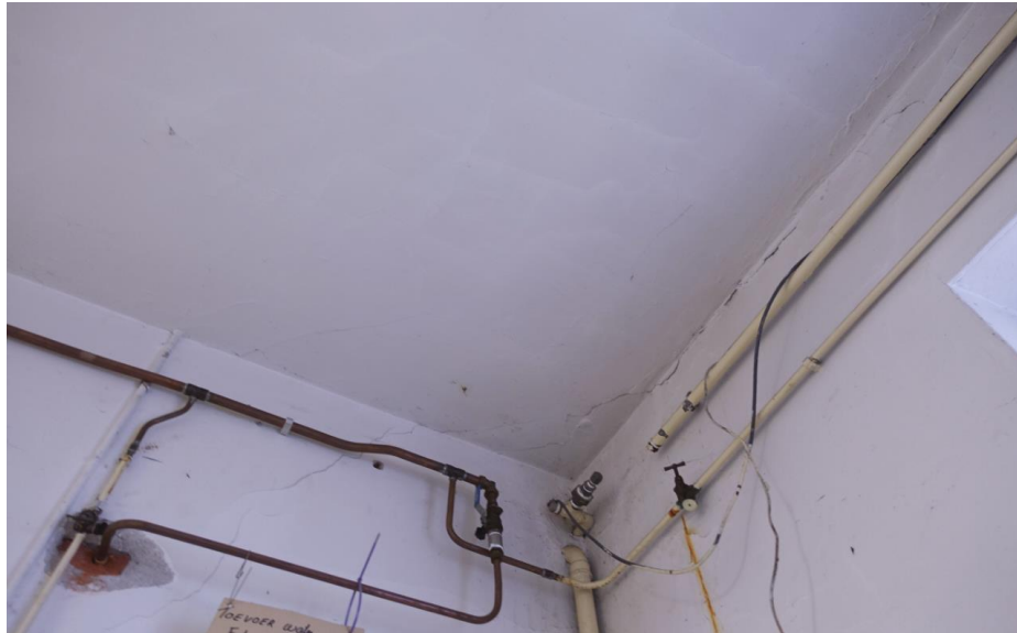
Een ouder stucplafond, mogelijk stammend uit 1940, aangetroffen boven de toiletruimte.
