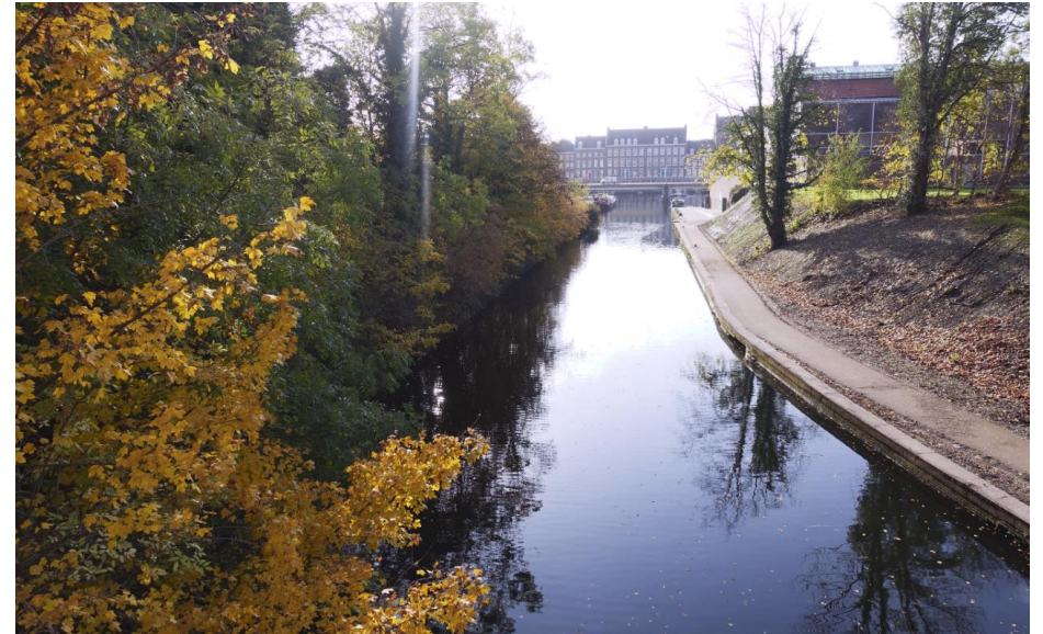
De in 1865-1870 verbrede verbinding tussen het Bassin en de Zuid Willemsvaart, gezien vanaf de voormalige spoorbrug richting het zuiden. Rechts is het voetgangerspad zichtbaar dat aan de westzijde van het verbindingskanaal is aangelegd.
