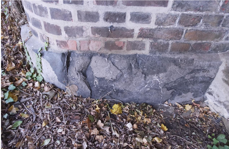
Detail van de hardstenen plint waarop de pijlers zijn gebouwd, zoals hier aan de oostzijde.
