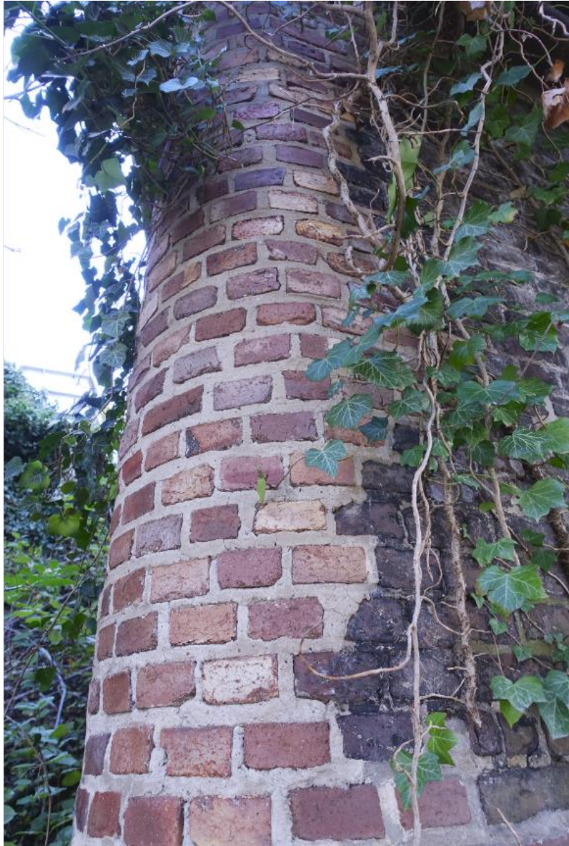
Het metselwerk bij de pijlers is in 1986 deels schoongespoten en opnieuw gevoegd met een plat volle voeg.
