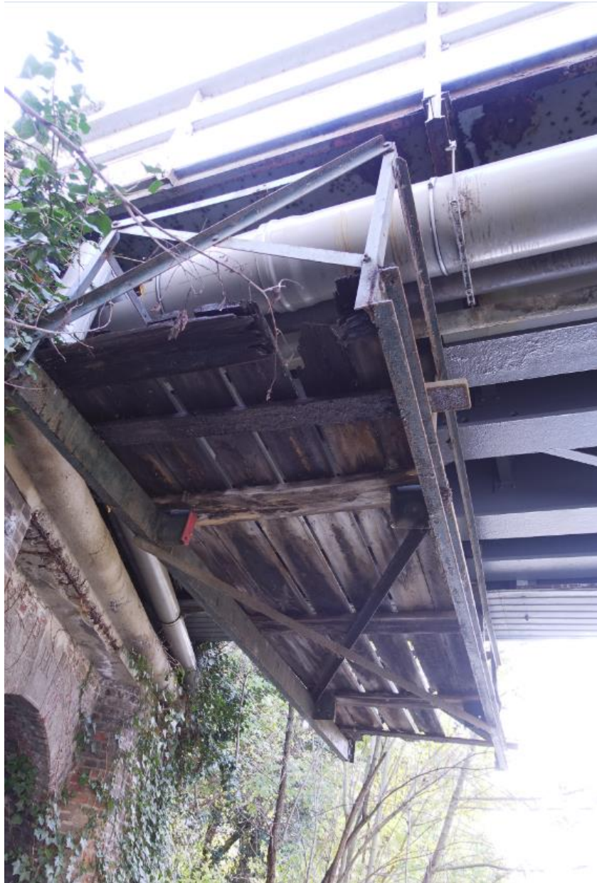
De verfwagen aan de onderzijde van de brug.
